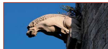
Gargouille surveillant le mur d'enceinte.
